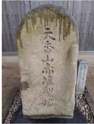
石材表面が酸性雨を吸収して様々な反応が生じている。
