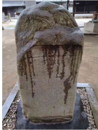
石材表面が酸性雨を吸収して様々な反応が生じている。
