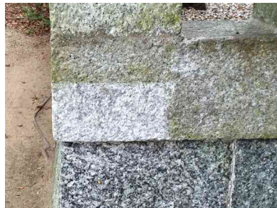
テスト施工(5月実施): 4ヶ月後も石材の表面は撥水し清浄。
