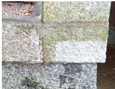
テスト施工(5月実施): 4ヶ月後も石材の表面は撥水し清浄。
