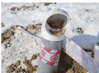
せり上がったガス抜パイプから腐敗した家畜の体液が溢れる
